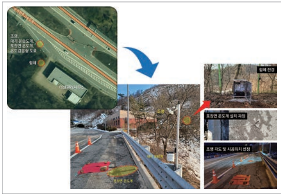
[그림 8] 조명 및 계측 시스템 현장 설치
