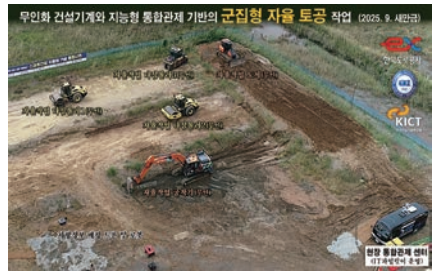
장비 자동화, 통합관제 기반의 군집형 자율 토공
