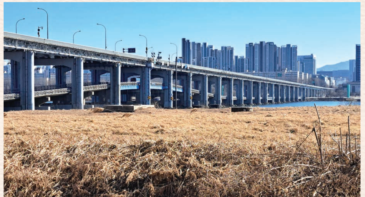
한강 유람선이 통과 가능한 형하교를 확보하려, 잠수교 중단선형이 아치형으로 높아졌다. ©이영천
