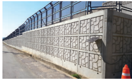
철도종합시험선로 건설공사 중 OPEN기타 (자립식옹벽) 군도20호선
