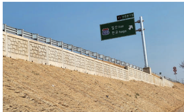
IC, JCT 가감속차로 개량공사 중 자립식옹벽
