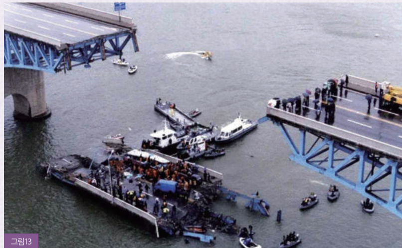
<그림13> 성수대교 붕괴 사고 현장 사진 (출처: 나무위키)
