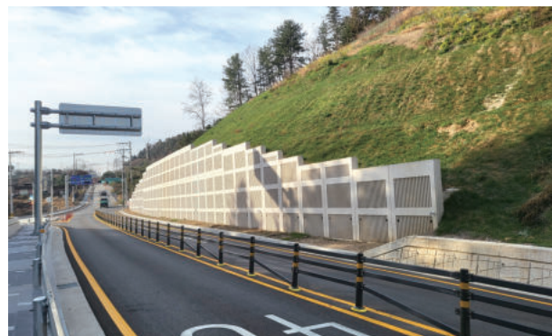
위임국도75호선 가평달전지구 위험도로 개선공사 중 자립식옹벽
