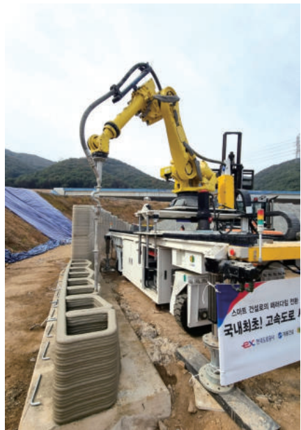
3DCP 기술로 옹벽 시공을 완료한 전경
