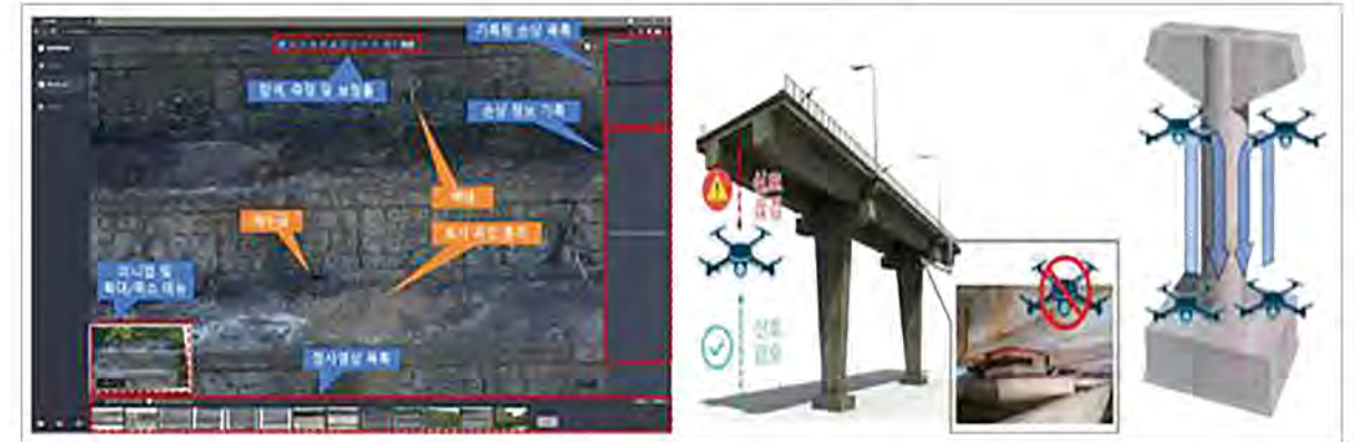
[그림 3] 드론을 이용한 도로 시설물 조사 사례: (좌) 사면 조사 플랫폼, (우) 교량 하부 조사 사례
