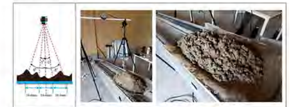
[그림 30] 실드 TBM에서의 굴착토의 정량적 측정
