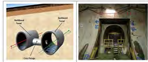
[그림 18] TBM 터널에서의 피난연락갱 NATM 시공
