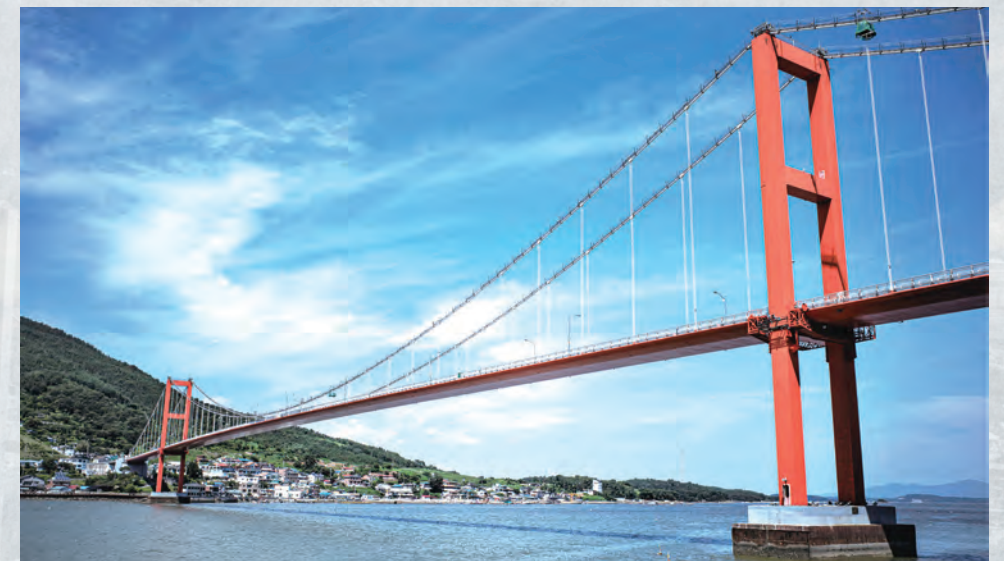
바다를 건너는 붉은 현수교, 남해대교의 위용. ©남해군청
