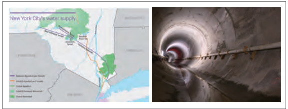
[그림 15] Delaware Aqueduct Tunnel
