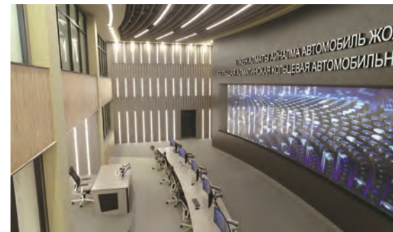
[사진 3] 교통관리센터 전경
