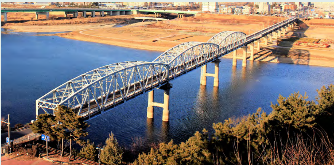
금강을 건너는 트러스 금강철교. ©공주시청
