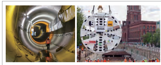
[그림 23] 베를린 U5 프로젝트에서의 터널 굴착(TBM)
