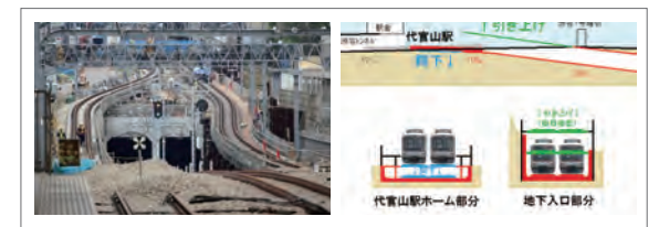
[그림 10] 철도 지하화의 기술 문제 (운행 중 지하화 공사 및 지상-지하 전환공사)
