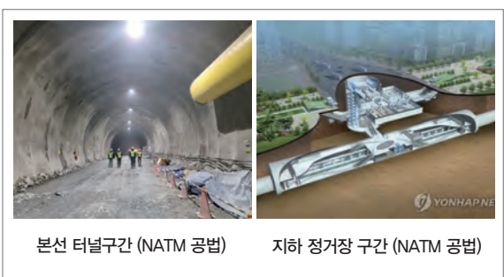
[그림 33] GTX-A 시공(본선 터널 및 터널 정거장)
