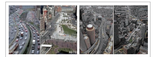
[그림 19] Boston Big Dig 지하도로 프로젝트 (Before Vs. After)
