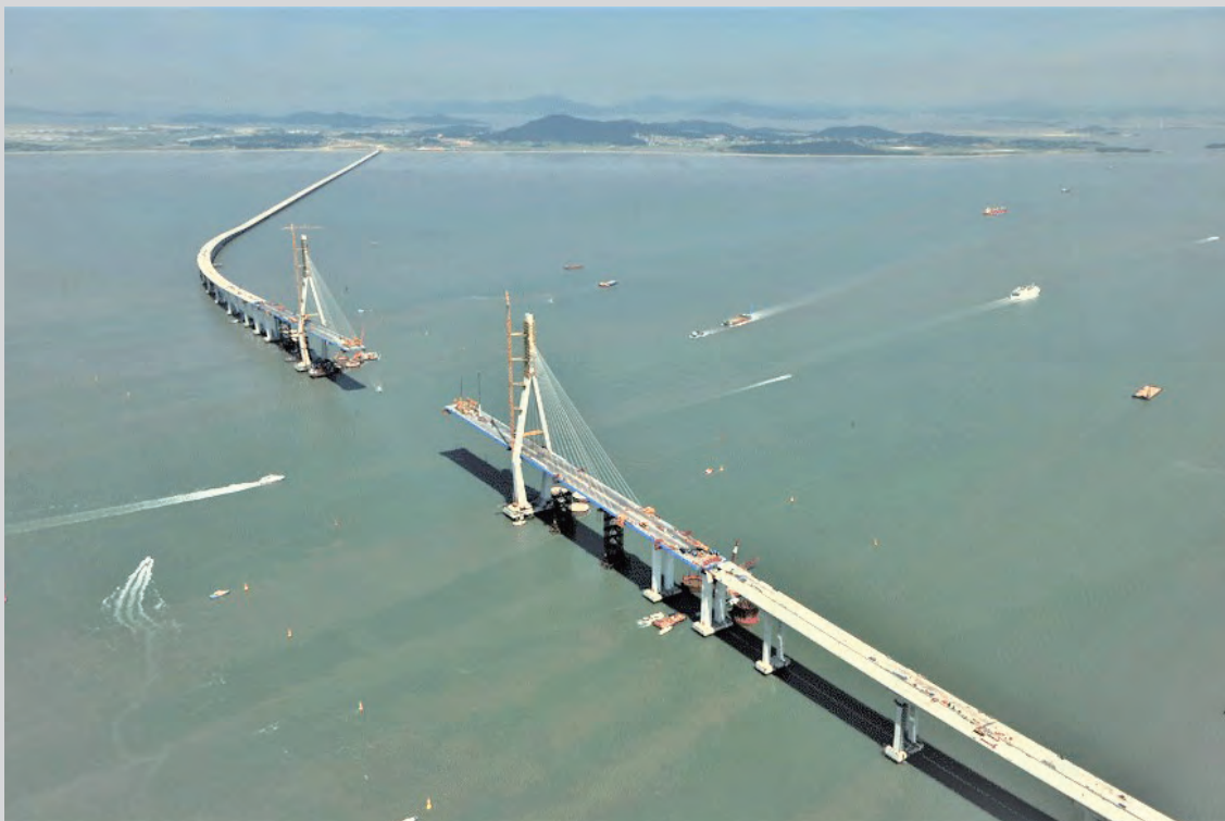
해상에 수십 킬로미터 교량을 설치하는 장면. 인천대교 사장교 구간 공사 장면이다. ©인천대교(주)
