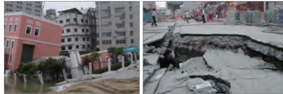
[그림 11] 상하이 메트로 TBM 터널 붕락사고(중국 상하이, 2003)
