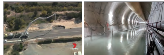
[그림 13] Forrestfield 공항철도 TBM 터널 붕락사고(호주 Perth, 2018)
