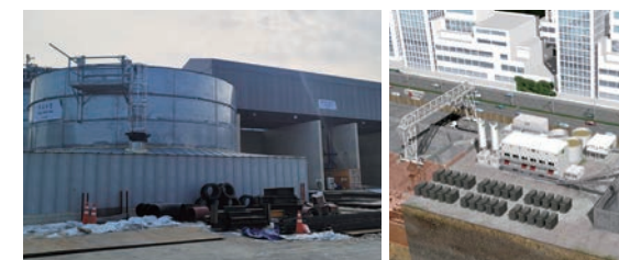
[그림 25] TBM 터널 작업장 계획
