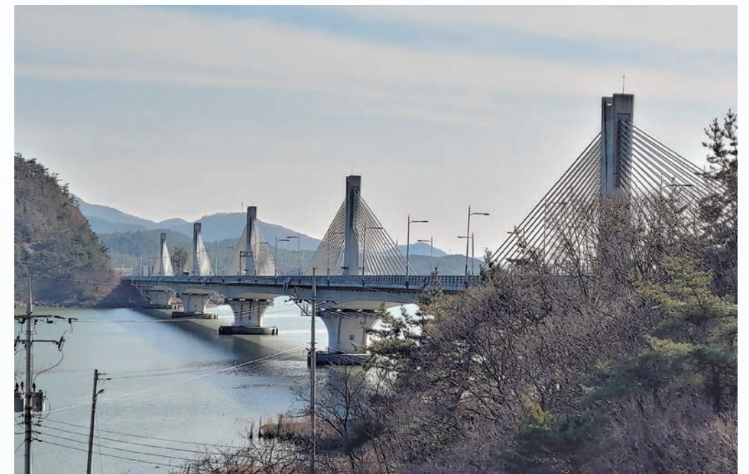
영산강을 건너는 '1면식 연속 5주탑 엑스트라-도즈드(ED)'인 무영대교. ©이영천
