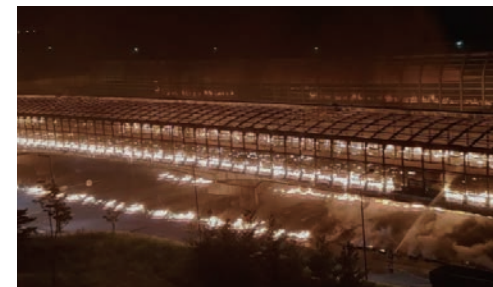
〈사진 3〉 용인 고가도로 방음터널 화재 4)
