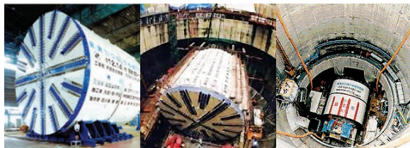
[그림 25] 대심도 지하유틸리티 터널(도쿄 외곽방수로) - 쉴드 TBM과 수직구
