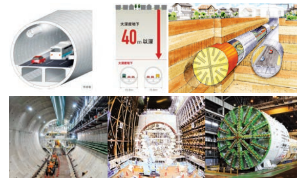
[그림 21] 대심도 지하도로(도쿄 외곽순환도로) - 쉴드 TBM 터널
