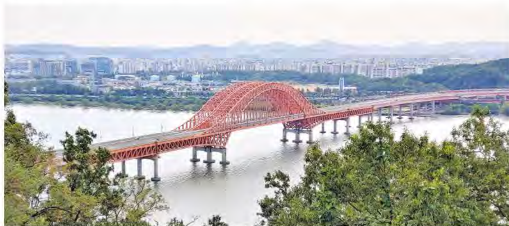
행주산성 꼭대기 오르는 길에서 바라본 방화대교. 인천공항 고속도로 사절답게, 날아오르는 비행기를 형상화한 아치 트러스로 중임을 장식한 유려한 모습. ©이영천
