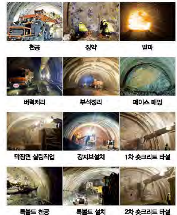
[그림 18] NATM 공법 시공순서
