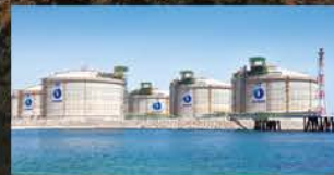
삼척 LNG 저장탱크
