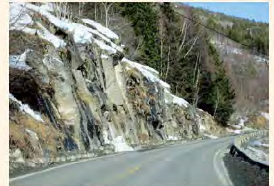
노출암반을 도입한 도로경관
