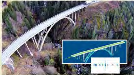
그림 5. Slava Bridge 전경 및 디지털 트윈 (출처: NPRR)
