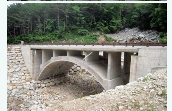
유송잡물 차단시설과 통수단면을 확보한 교량
