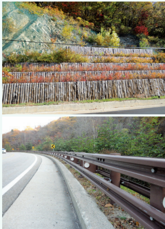
전면 목재부착 계단식 옹벽, 갈색 가드레일
