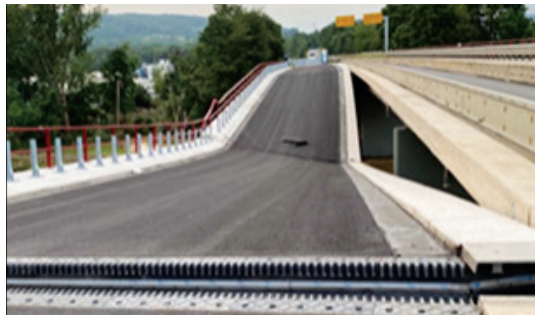
<그림 4> 교량 피해 사례 (독일 교량)
