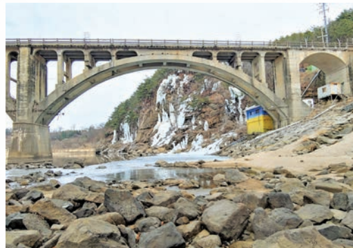
남한이 만든 승일교 남쪽 모습. 아치 위에 3개 현수 기둥을 세워, 총 4칸의 형하를 만든 모습이 뚜렷함. ©이영천
