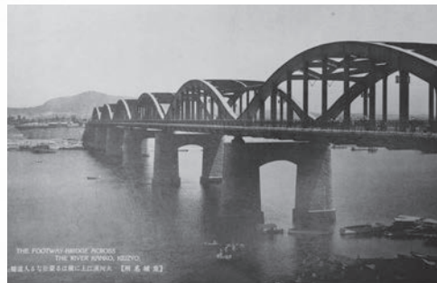
1936년 10월 완공된 6경 간 현대식 교량으로 지어진 한강인도교, 교각의 재료와 구조 등이 지금의 모습과는 확연히 다름을 확인할 수 있음. ©서울역사박물관
