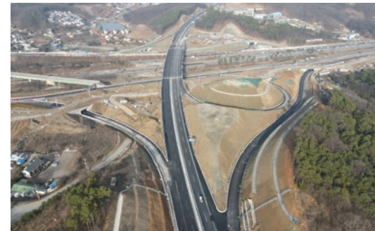
〈그림 15〉 서용인JCT 전경
