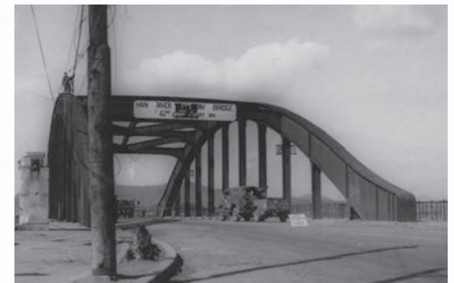
한국전쟁 중 미군 공병대가 임시로 수리해 사용 중인 1951년 여름의 한강인도교 모습. 곳곳이 파괴된 전쟁의 상흔이 보임. ©서울역사박물관
