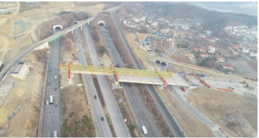
〈그림 11〉 서용인JCT : IPC Girder교
