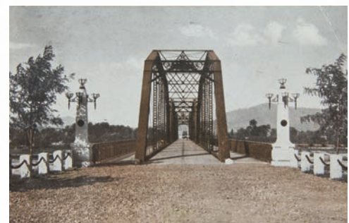
1917년 한강철교 A선 트러스 부재를 뜯어내 가설한 옛 인도교 모습. 가운데 4.5m 폭의 차로와 양쪽으로 각각 1.6m 보행자 공간이 뚜렷함. ©서울역사박물관
