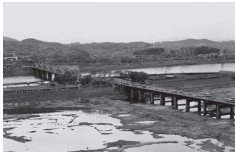
1979년 한강인도교 모습. 노들섬을 중심으로 남쪽 노량진파는 6경 간 아치 교로 북쪽 용산파는 강판형교 모습이 뚜렷함. ©서울역사박물관
