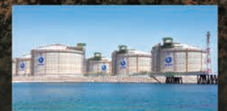
삼척 LNG 저장탱크
