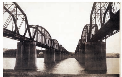
완성된 한강철교 A선과 B선의 1913년 이후 모습. 두 개의 한강철교는 경부선 개통 이후 증가하는 철도 교통수요에 부응하는 교량으로 건설되었음. ©서울역사박물관
