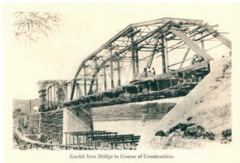
1900년경 한강철교 A선을 트러스교로 가설하는 모습. 경인선 전 구간 개통과 함께 한강을 건너는 최초의 근대식 교량으로 탄생하였음. ©서울역사박물관
