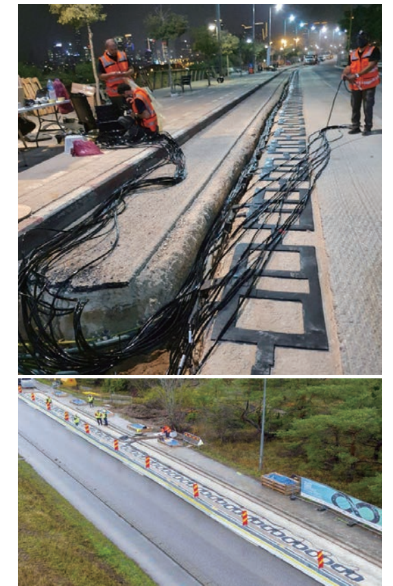
<그림 6> 무선충전도로 실제 시공 사례 6)
