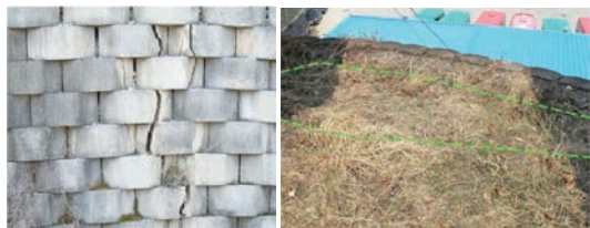
〈사진 4〉 Detail of the Cracks 〈사진 5〉 Settlement behind the SRW
