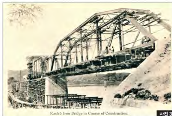
1900년 한강철교를 시공하는 사진. 곡형 외렌 트러스로 공사 중인 장면이 생생하다. ©서울역사아카이브
