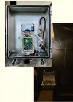
〈그림 8〉 게이트웨이 및 센서노드 설치
