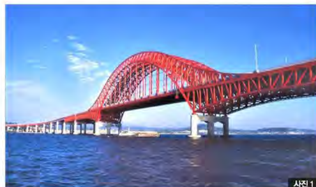
사진 1 인천공항고속도로 한강 구간을 횡단하는 방화대교 모습. 다리 중간에 상로 트러스와 하로교인 아치 트러스를 짜 넣어 멋들어진 풍경을 연출했다. ©신공항하이웨이(주)
