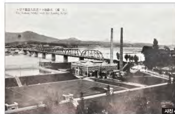
1917년 만들어진 최초 한강인도교 모습이다. 한강철교 A선을 개수하면서 뜯어낸 트러스를 재사용해 인도교를 만들었다. ©서울역사아카이브
