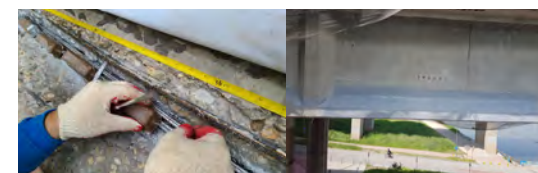
거더측면 희생양극장치 설치 및 단면보수
