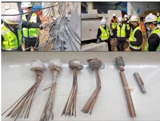
〈그림 6〉PSC 철거교량 현장점검 및 거더일부와 부속장치 확보
