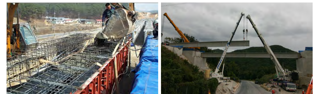
〈그림 1〉 PSC-I형 거더교의 제작 및 가설
