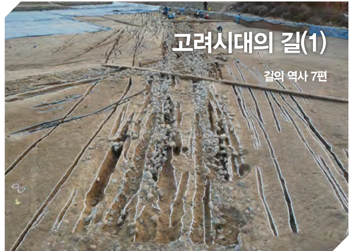
대구봉무동 유적에서 발견된 고려시대 도로 노출 전경 (사진: 영남문화재연구원)
