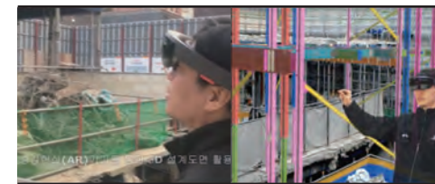
〈그림 6〉 AR을 활용한 시공 전 현장 확인(건축현장)
