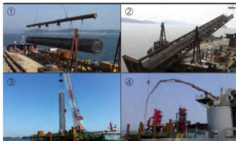
① Lifting Frame 이용 철근망 운반 ② Roll Up Jig Frame 이용 철근망 세우기 ③ 철근망 양중 및 근입 ④ 현장타설말뚝 콘크리트타설
