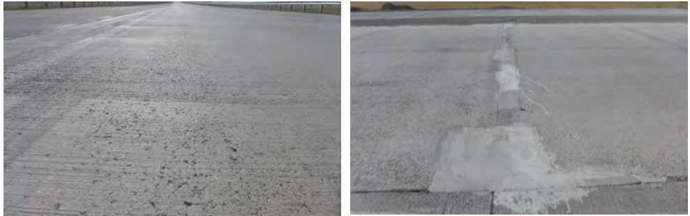
〈그림 5〉알마티 ~ 비슈케크 고속도로 아스팔트 포장 파손
