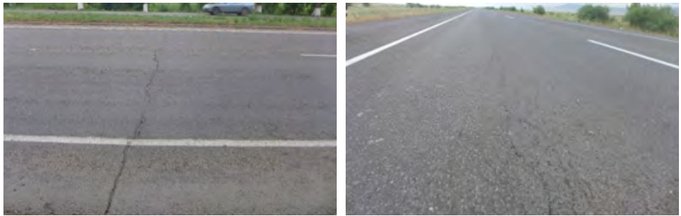
〈그림 5〉알마티 ~ 비슈케크 고속도로 아스팔트 포장 파손
