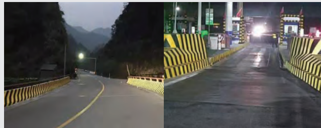
도로 방호벽 및 톨게이트 진입구 반사페인트 야간 반사효과
