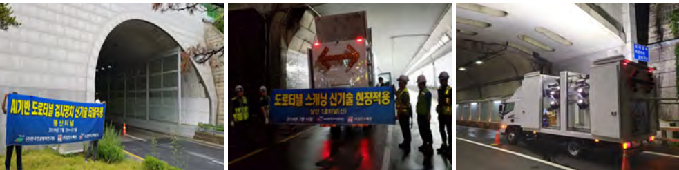
봉산터널 현장적용 전경
