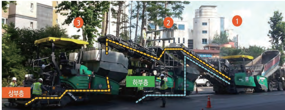
(주)포이닉스에서는 복층포설 전용장비인 In-Line Paver 1set을 국내 최초로 도입하였다.
