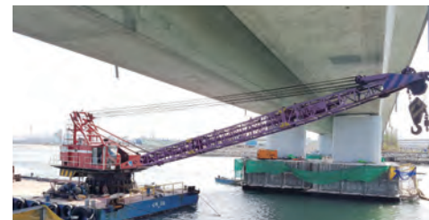
지엘기술이 섬진대교 보수보강 공사를 진행하는 장면
