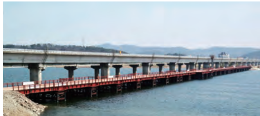
지엘기술이 성주대교(구) 개축공사 중 가교설치 및 철거공사를 진행하는 장면
