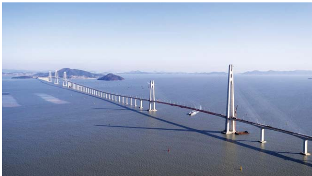
교량 건설 당시 3주탑 현수교 시공 전경. 대림산업이 시공을 맡았다. (출처: 신안군)
