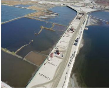
주교량(만경대교) 설치 전경 (3공구)
