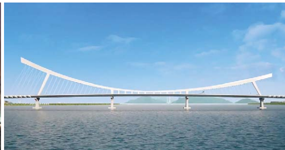
새만금 남북도로(2축) 3공구에 들어설 만경대교는 세계최초 비대칭 리버스아치교가 적용되었다.(주)대림산업
