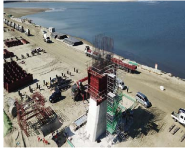
주교량(만경대교) 교각 설치 (3공구)
