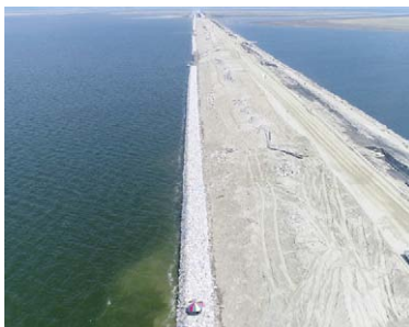
연약지반처리(동서도로 1공구) 피복석
