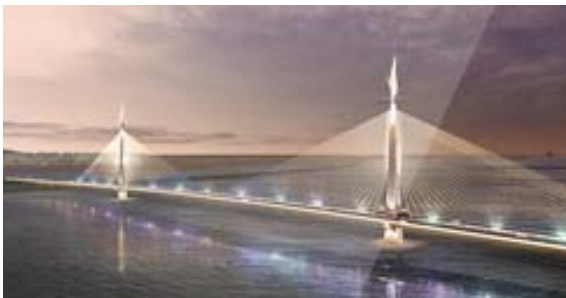
새만금 남북도로(2축) 2공구에 들어설 새만금대교는 2주탑 사장교로 건설된다.(주)포스코건설
