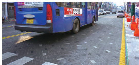
완공된 차도블록 포장 현장(조치원로)
