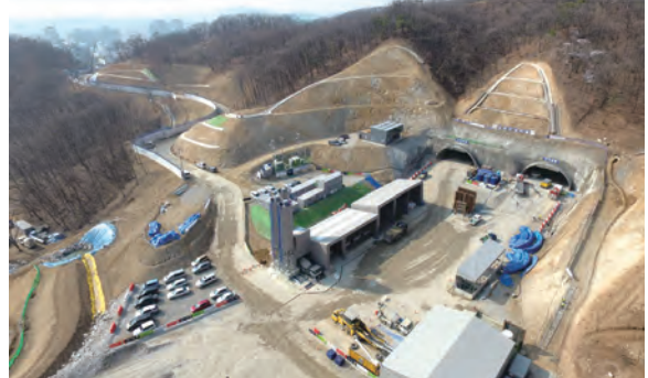
제11공구 터널 입구 전경
