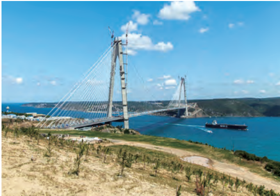
〈그림 6〉 보스포루스 3교 시공 전경
