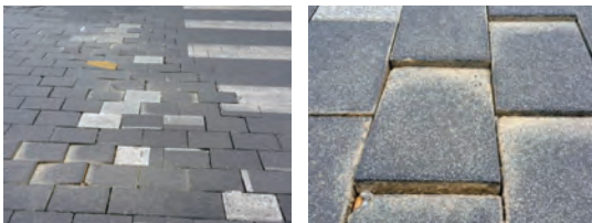
대전시 중교로 차도블록 포장 (설치 1년 후 모습)
