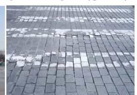
광화문 돌 포장 파손(버스 정류장) 광화문 돌 포장 파손(횡단보도)
