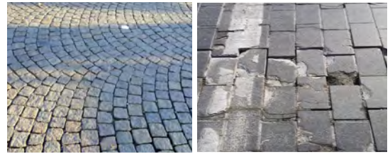
상젤리제 거리 돌 포장 패턴(아크패턴) 광화문 돌 포장 패턴(일자패턴)
