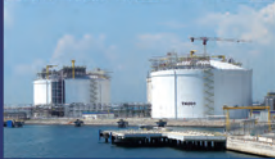
싱가포르 LNG 저장탱크
