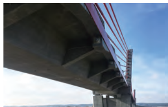
VISTILA River 교량 전경
