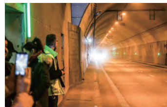
The Dead VISTILA River 터널 및 관제센터
