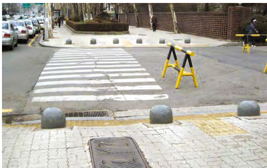
〈그림 3〉 볼라드 설치 사례(1)
