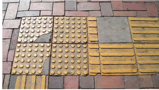
〈그림 18〉 플라스틱 점자블록 파손 사례
