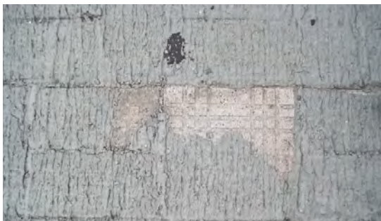
〈그림 12〉 미끄럼 방지포장의 접착력 저하로 타일블록 노출 사례
