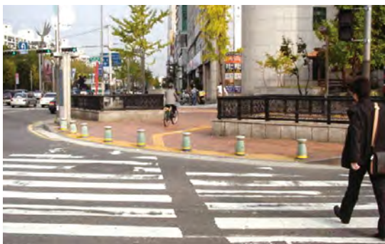
〈그림 4〉 볼라드 설치 사례(2)
