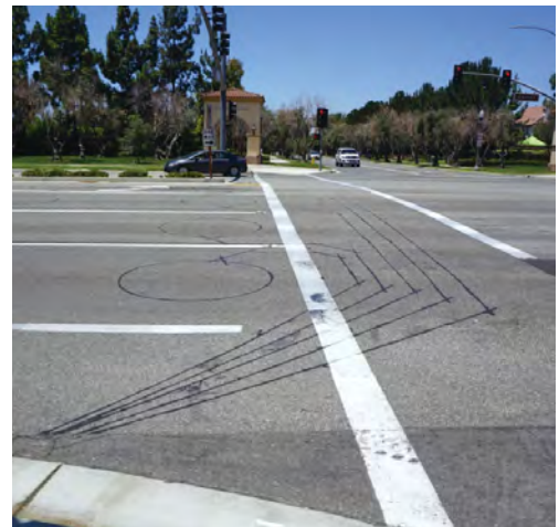
〈그림 2〉 루프 검지기 설치 사례
