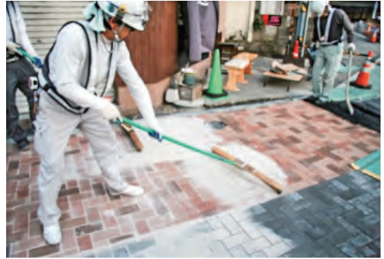
〈그림 6〉 밀대를 이용하여 줄눈 모래 포설(일본사례)
