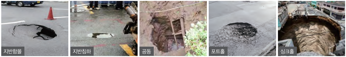
〈그림 1〉지반함몰 형태 사진
