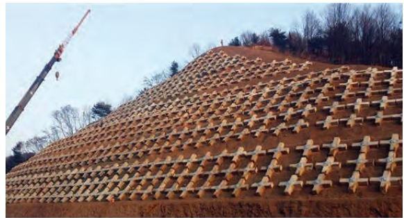
세이프티 앵커 시공전경
