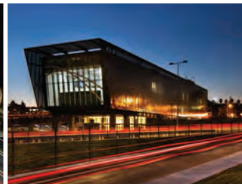
〈그림 14〉 터널 O&M 빌딩 전경
