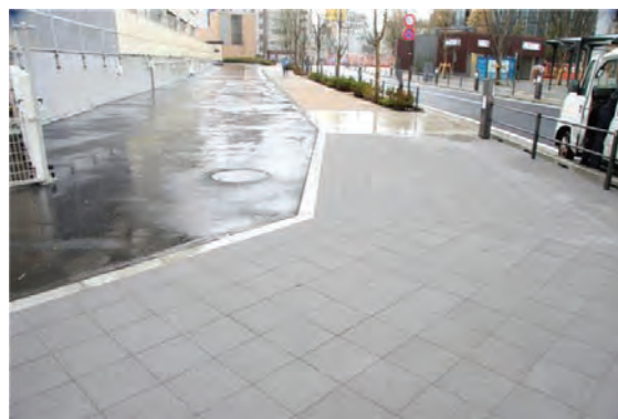
투수블록 설치 사례-2 (위 : 불투수 포장, 아래 : 투수블록 포장)
