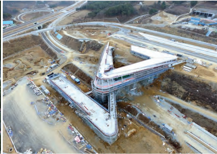
드론으로 촬영한 내린천 휴게소 공사 전경
