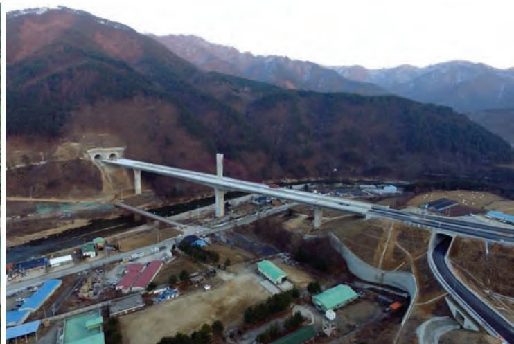
동홍천~양양고속도로에서 유일한 경관 교량 내린천교 전경
