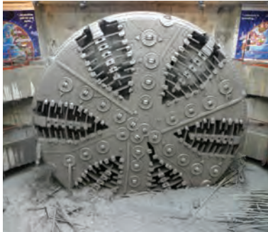
〈그림 9〉 TBM 관통(Break Through) 전경
