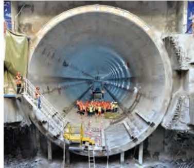
〈그림 10〉 터널 굴착 및 세그먼트 시공 완료
