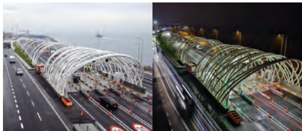
〈그림 13〉 터널 입출구 구조물의 낮과 밤의 전경
