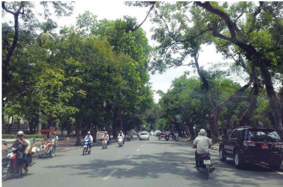
도로노면 파손 및 다양한 차종의 혼재 현황
