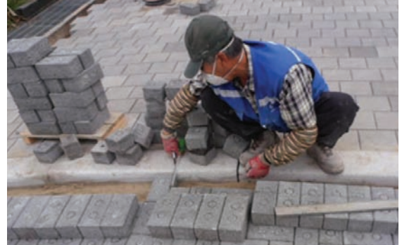
우리나라 보도블록 시공 현장
