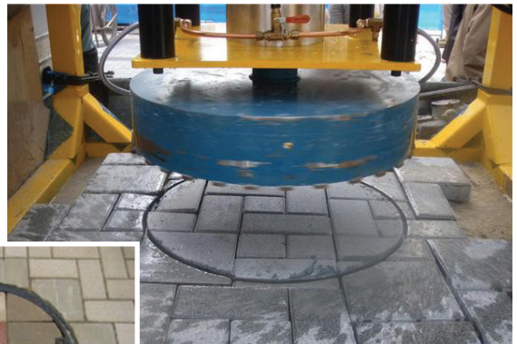
조화맨홀 시공 사례
