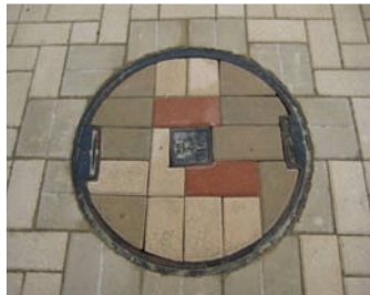
정교한 맨홀 시공(조화맨홀)
