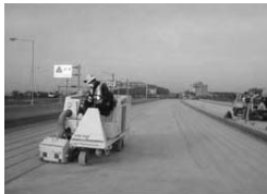
01. 교면절삭 약한 레이턴스층 제거 및 바닥 슬래브에 2mm 내외의 요철 형성
