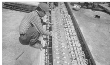
② 신축이음장치 설치
