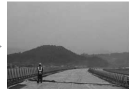
04. 표면건조포화상태 유지-비닐덮기 바닥판 물청소 후 건조방지
