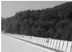
05. 레이아웃부 받침대 설치 포장 Final면이 레일 받침한 대로 나타나므로 정교하게 설치
