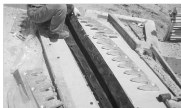
⑤ 일체형 고무방수재 설치
