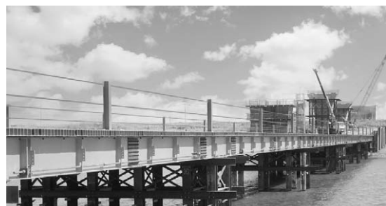
GTB 공법 적용현장(나주/140m)
