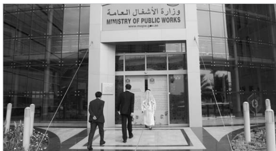
UAE 공공사업부 청사 전경
