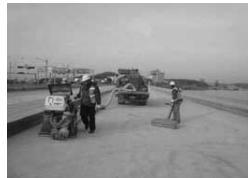
02. 슛블라스팅 교면절삭 후 남은 레이턴스 제거
