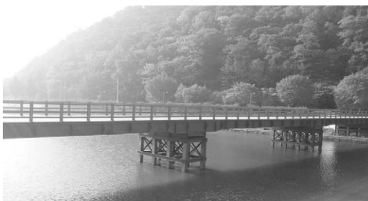
GTB 공법 적용현장(영주/96m)
