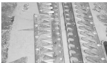
④ 신축이음장치 상판 개방
