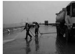
03. 고압 물청소 교면절삭 요철에 남은 미세먼지 완전제거
