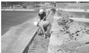
① 후타콘크리트 철거 및 정리
