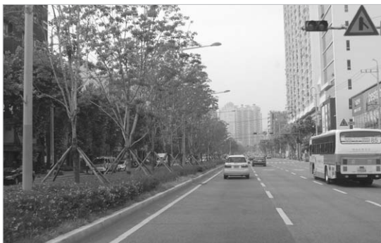
녹지중앙분리대 (부산시 구간)
