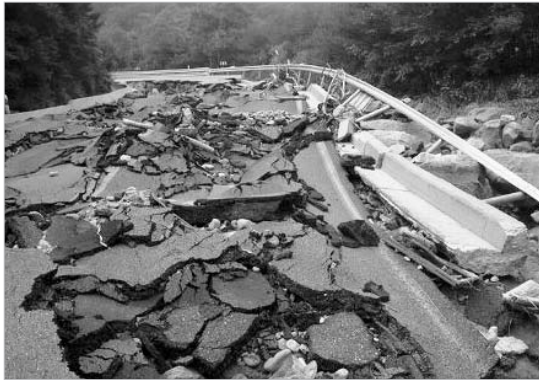
수해로 파괴된 한계령 도로
