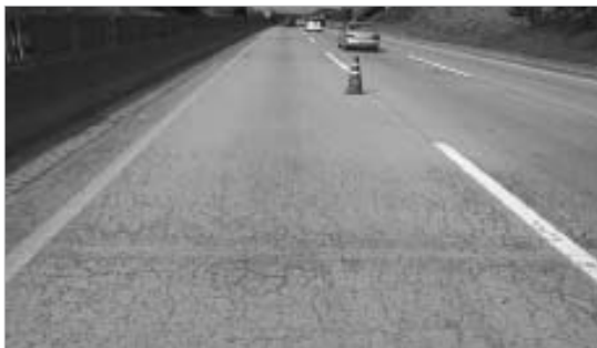
〈그림 2〉 포장 ASR 발생에 의한 포장파손
