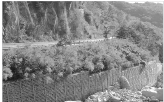
성토부 개비언 옹벽
