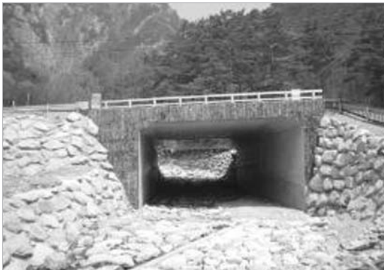
자연소재를 사용하였으나 인공적인 분위기가 두드러지는 시설물
