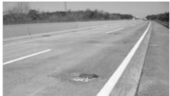
〈그림 2〉 포장 ASR 발생에 의한 포장파손
