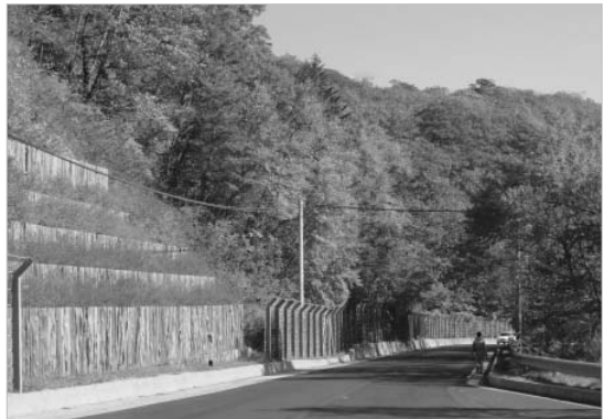
친환경성이 확보된 한계령 도로
