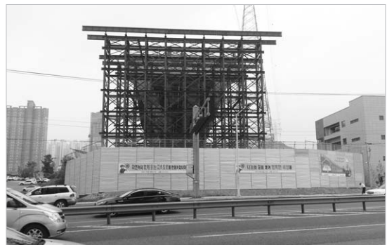
〈그림 11〉 차폐시설 및 안전 현수막 설치
