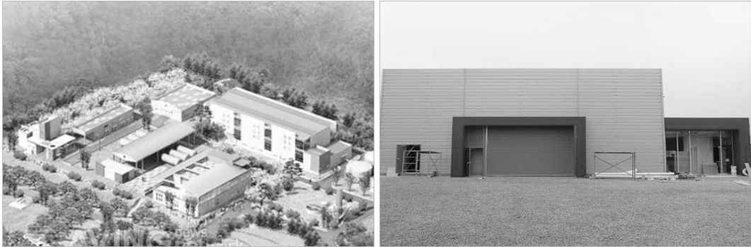
〈그림 5〉 부산 기장군 해수담수화 테스트베드 조감도(좌) 및 대용량 파일럿 플랜트(우)
