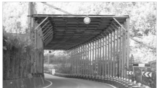
건천대교 하부 (청원~상주간 고속도로 3공구)
