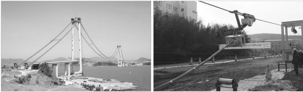
〈그림 4〉 현수교 케이블 가설장비 및 공법 : AS공법(좌), PPWS(우)
