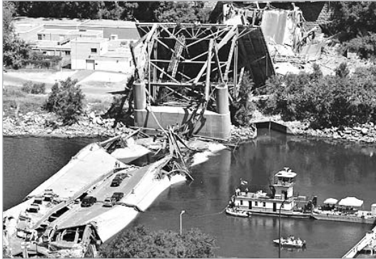
〈그림 2〉 2007년 미국 I-35W Mississippi River Bridge 붕괴사고
