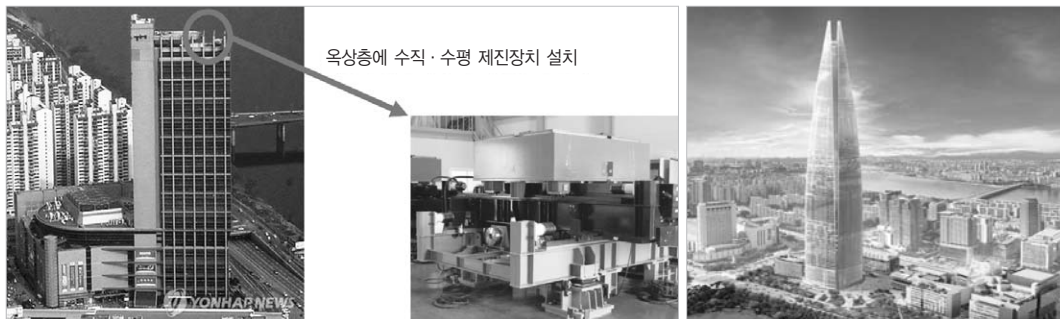
〈그림 8〉 테코노마트 제진장치 설치(좌) 및 롯데월드타워(우)
