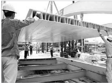
〈사진 1〉 청계천 복원공사 비우당교 (2004)
