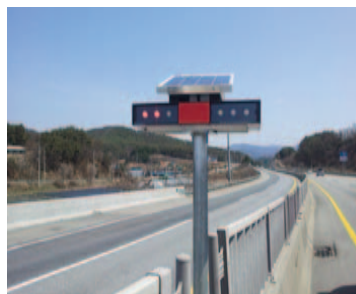
경광등 설치 (12개소)
