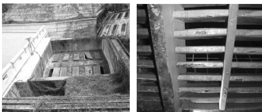
〈그림 12〉 외기 환경에 노출된 갯문 열화(좌) 및 캐노피 열화로 인한 박락(우)
