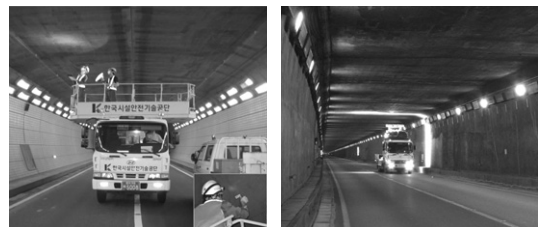
〈그림 13〉 도로터널의 일반적인 점검 전경과 스캐닝에 의한 점검 전경
