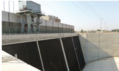
파키스탄 뉴봉 수력발전소 건설공사
