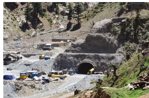
로와리 철도 터널 공사 | 북측 입구
