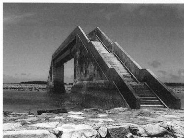
인도교(シールガチ橋, 久米島町)
