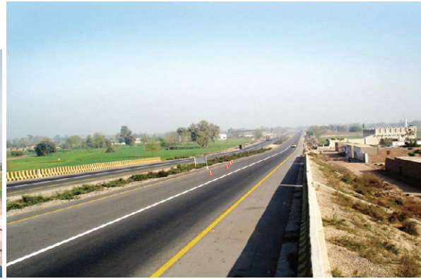
물탄-미안차누 도로 공사
