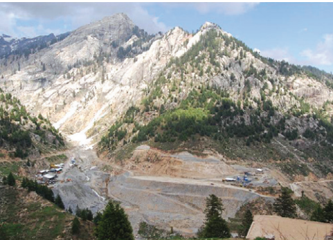
로와리 철도 터널 공사 | 남측 입구
