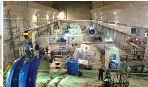
뉴봉 수력발전소 공사 | 기자재 설치
