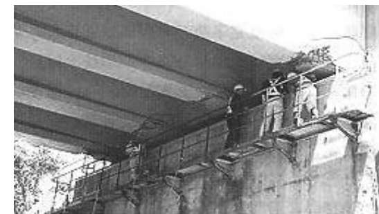
[사진 1] 점검로를 이용한 근접 점검
