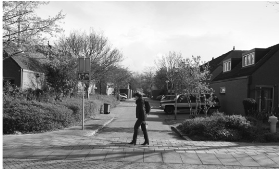
〈그림 14〉 본엘프 지구 입구 과속방지턱 설치
