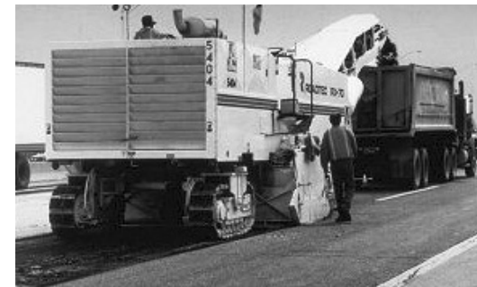
도로 포장 절삭 및 폐아스콘 상차
