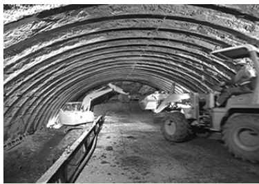
⑤굴착 및 라이닝 콘크리트 타설
