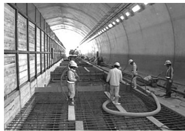
⑥인버트 콘크리트 타설 및 포장
