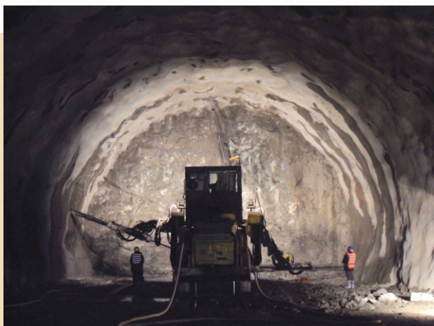
인제터널 굴착 시공 전경
