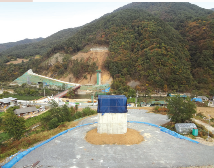
내린천교 교각 시공전경
