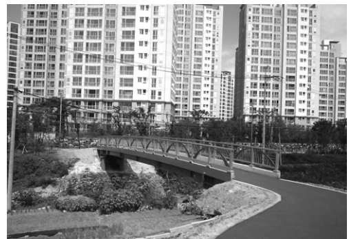
〈사진 1〉 하천횡단 자주식 자전거도로용 교량
