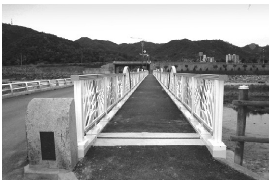
〈사진 2〉 교량측면부 자주식 자전거도로용 교량
