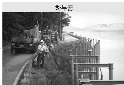
4. 파일캡 및 가로보 설치
