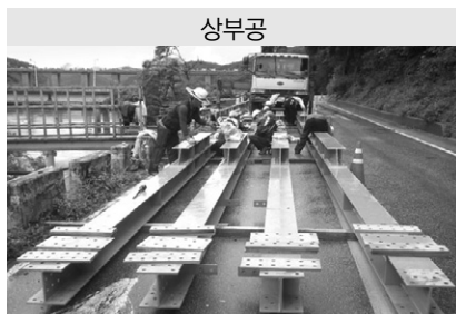
5. 상부주형 거더 조립
