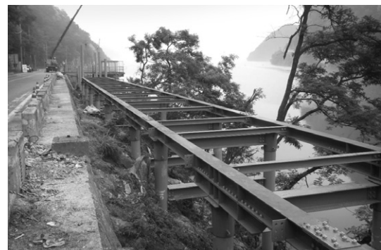
〈사진 3〉 법면부 자주식 자전거도로용 교량
