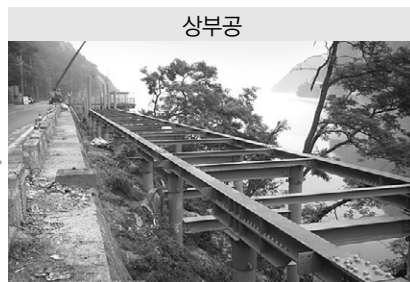
6. 상부주형 거더 설치
