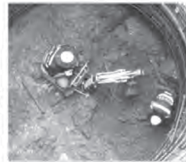
④ 굴착 및 굴착도 인양 소형 크레인 이용 굴착도 반출
