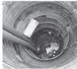
⑤ 변단면구간 Setting D4000mm ⇒ D3000mm 변단면
