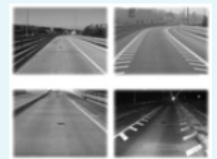
〈그림 11〉 Herringbone 설치 -여주분기점(상) 및 충주나들목(하)
