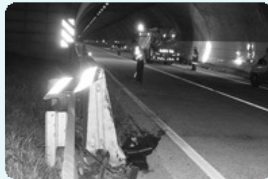
◀그림 1> 터널 전면에 설치된 이동형 콘크리트 방호울타리
