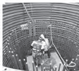
⑨ 철근망 조립 주철근 및 배력철근 조립
