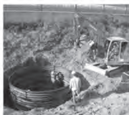
② Guide 철제 토류판 설치 정위치 시공용 철제토류판 설치
