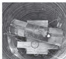
⑦ 기초 통과 지장물 보호 중간 지장물 보호 (철재보호공)
