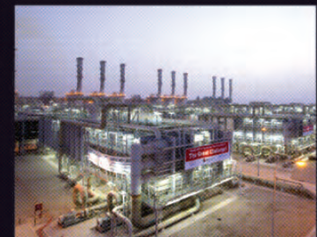
세계 최대 규모 담수화 플랜트 주베일 담수화 플랜트 (사우디 아라비아)
