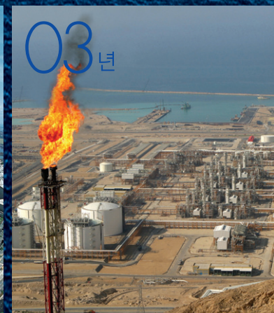
이란 사우스파 가스처리시설
